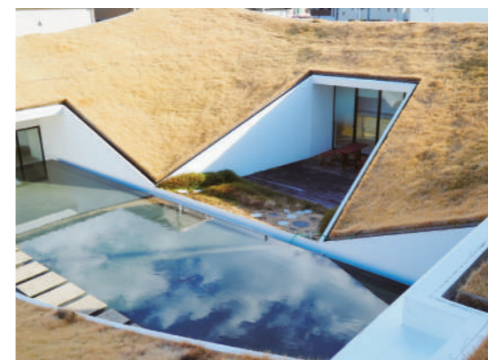
建物の中心にある青空を映す四角形の水盤
